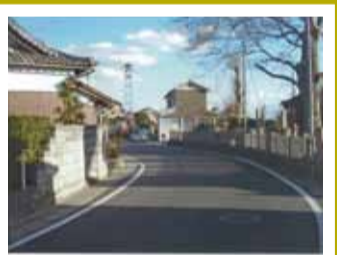
⑥荒神社前 道路が大きくカーブし見通し が悪い。
